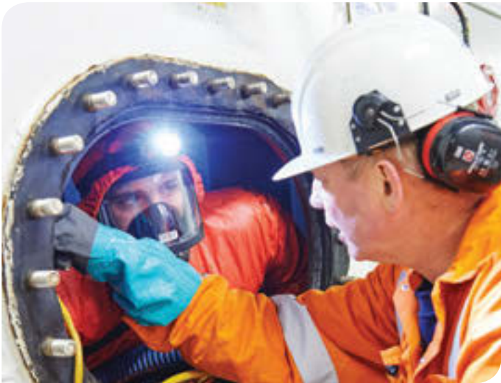
De tanks worden ieder jaar volgens een preventief onderhoudsschema geïnspecteerd.
