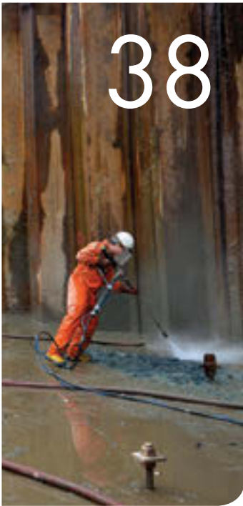
Samenwerken in een bouwkuip
